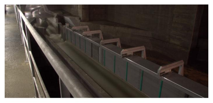
Après une étude du fonctionnement du système de déversoirs d'orage du Capelard, de la Maladière et de Berna, qui a permis de dégager une stratégie destinée à limiter la pollution du Léman, l'ouvrage du Capelard a été aménagé pour l'équiper d'un dégrilleur à grande capacité (14.7 m³/s).
